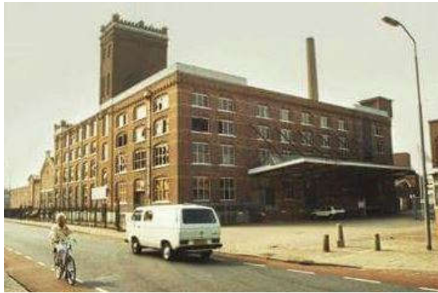
Voormalige jutefabriek Ter Horst - Rijssen
